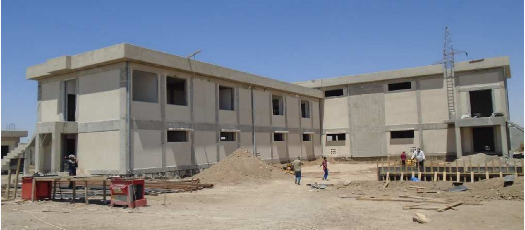
Trafo Merkezi Fotoğrafları
